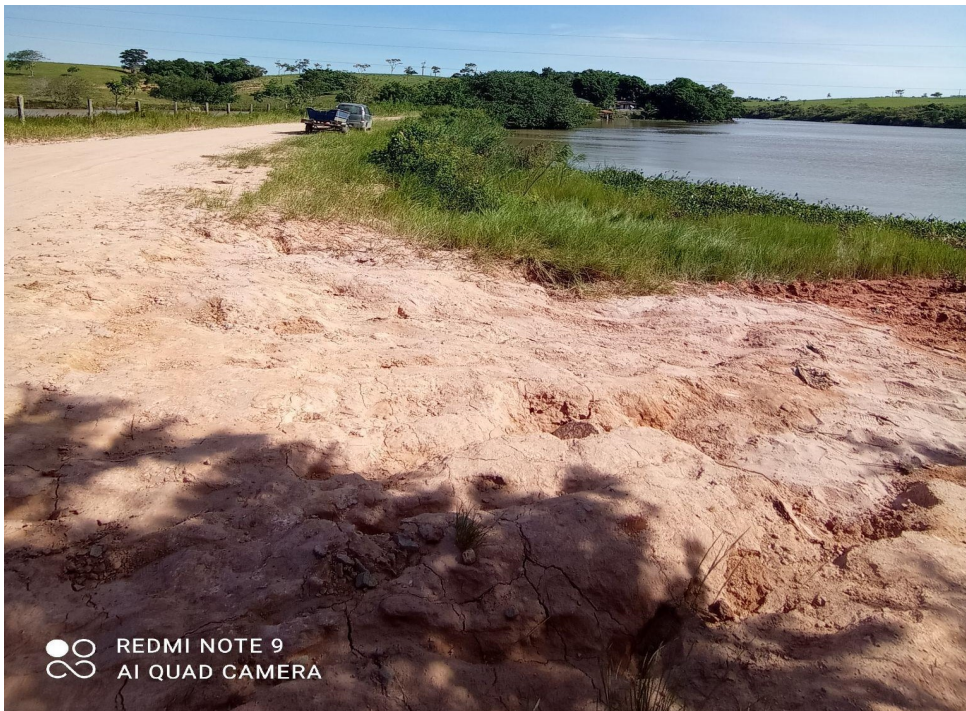
Figura 4b. Margem erodida. (Foto: Gabriela Marcolino,2022)
