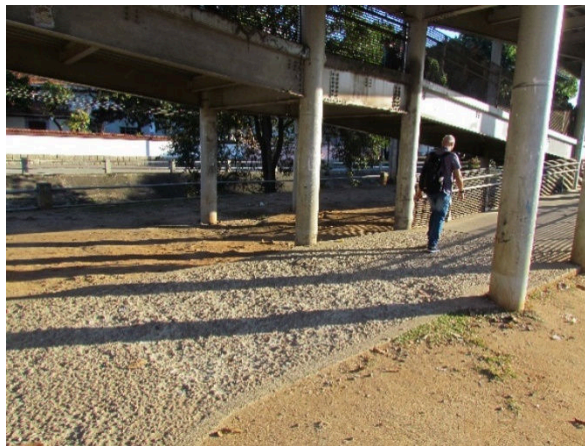
Figura 3. Passarela da Estação de trem sobre a Av. Radia Oeste, a mais próxima do CEFET.(Fonte: arquivo pessoal do autor 2019)
