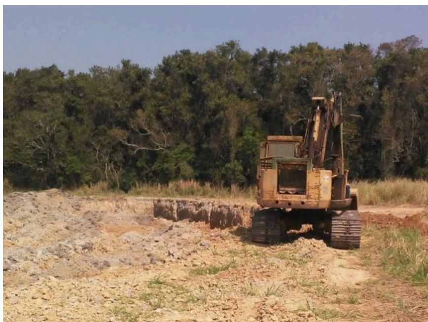
Figura 6. Retirada do material nas jazidas. Fonte: Lídia Amorim (2020)
